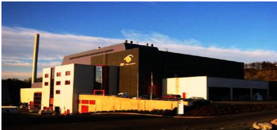
Figur 2.4.3: Avfallsforbrenningsanlegg i Bergen, Rådalen
